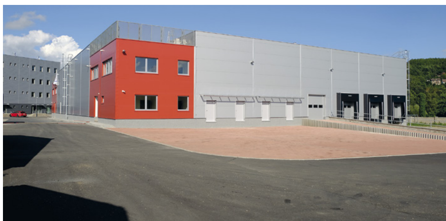
Hala z 2. etapy výstavby
